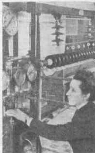
На Славянском арматурно-изоляторном заводе имени Артема. Лаборантка А. Т. Малеева проводит испытание подвесных высоковольтных изоляторов.
