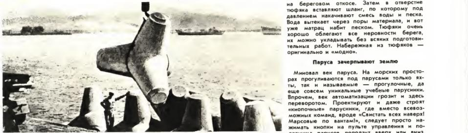
на береговом откосе. Затем в отверстие тюфяка вставляют шланг, по которому под давлением накачивают смесь воды и песка. Вода вытекает через поры материала, и вот уже матрас набит песком. Тюфяки очень хорошо облегают все неровности берега, их можно укладывать без всяких подготовительных работ. Набережная из тюфяков — оригинальна и «модна».
