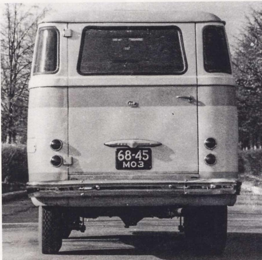
Сзади на РАФ-977В ставили большую распашную дверь
