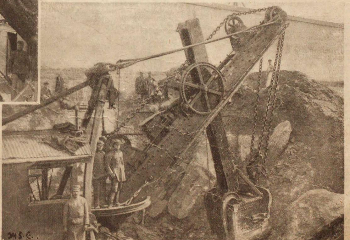
подвезется ж.-д. платформы. Экскаватор черпает грунт и камни и сам кладет их на платформы, а платформы с этим грузом отвозятся к месту засыпки паровозами.
