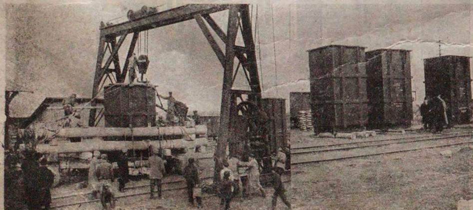
Перевозка трансформаторов для Шатурстроя в Москве. На с'ездах: вверху—момент погрузки их на специальную телегу. Справа—выгруженные трансформаторы на ст. Московск.-Нижнегор. ж. д.
