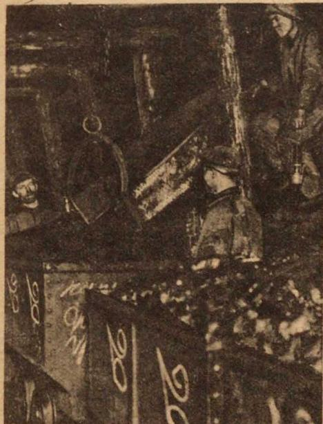
Механизированная подача угля на вагонетки посредством конвейера (Семоновский пласт, Сталинский округ)
