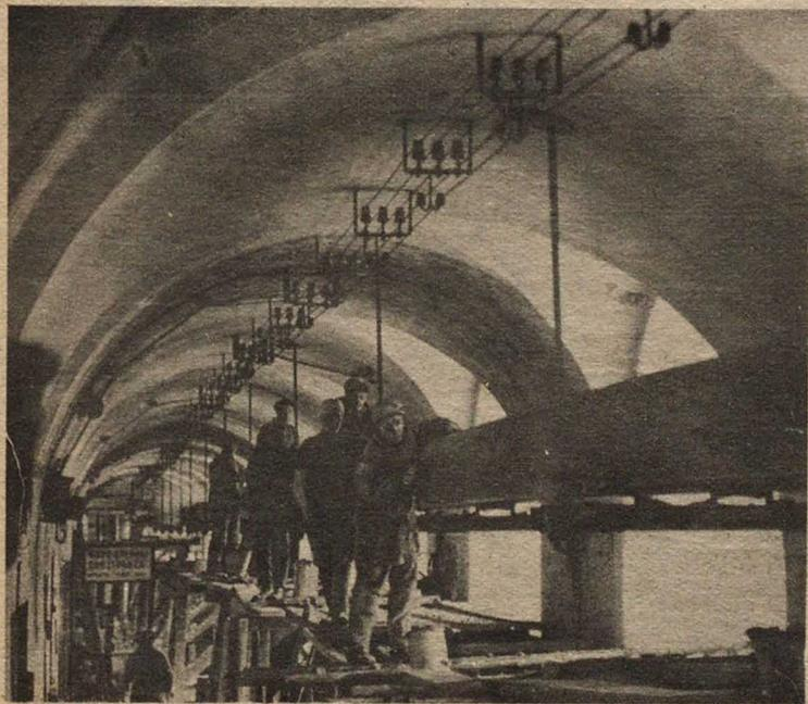
Установка теплофикационной изолированной проводки в здании б. Гостиного двора
