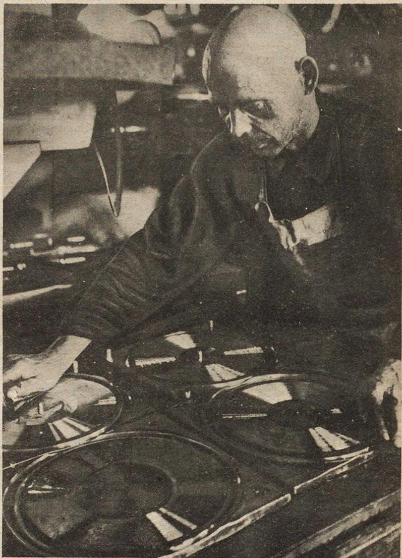
Прессовка граммофонных пластинок. Прессовщик протирает матрицу
