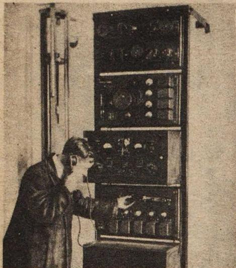
Телефонный завод „Красная Заря“ (Ленинград) изготовил впервые в СССР комплекты приемно-передающих станций для многократного телефонирования токами высокой частоты и приступил к их серийному производству
