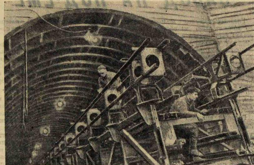
на строительстве станции метро «Серпуховская». Бригада Зайдева за монтажом эскалатора.
