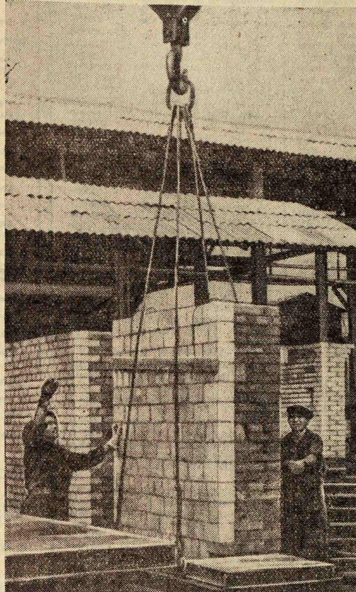
послужное устройство опускает блок ровно на высоту ряда уложенных кирпичей. Так протекает работа, облегченная механизмами. Готовые блоки доставляются на двор. Этот двор является как бы своеобразной кладкой будущего здания. Через четырнадцать дней 800 спаянных раствором кирпичей приобретают прочность скалы. Тогда блоки при помощи крана устанавливаются на трейлеры и отправляются на стройки.
