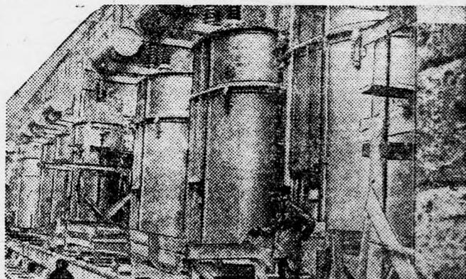
10 октября состоится торжественный пуск Днепростроя. На снимке — силовые трансформаторы Днепровской государственной электростанции. Особенность этих трансформаторов заключается в том, что охлаждение производится змеевиками (многочисленными изогнутыми трубами), расположенными внутри трансформаторов. Вода нагревается центробежными насосами.
